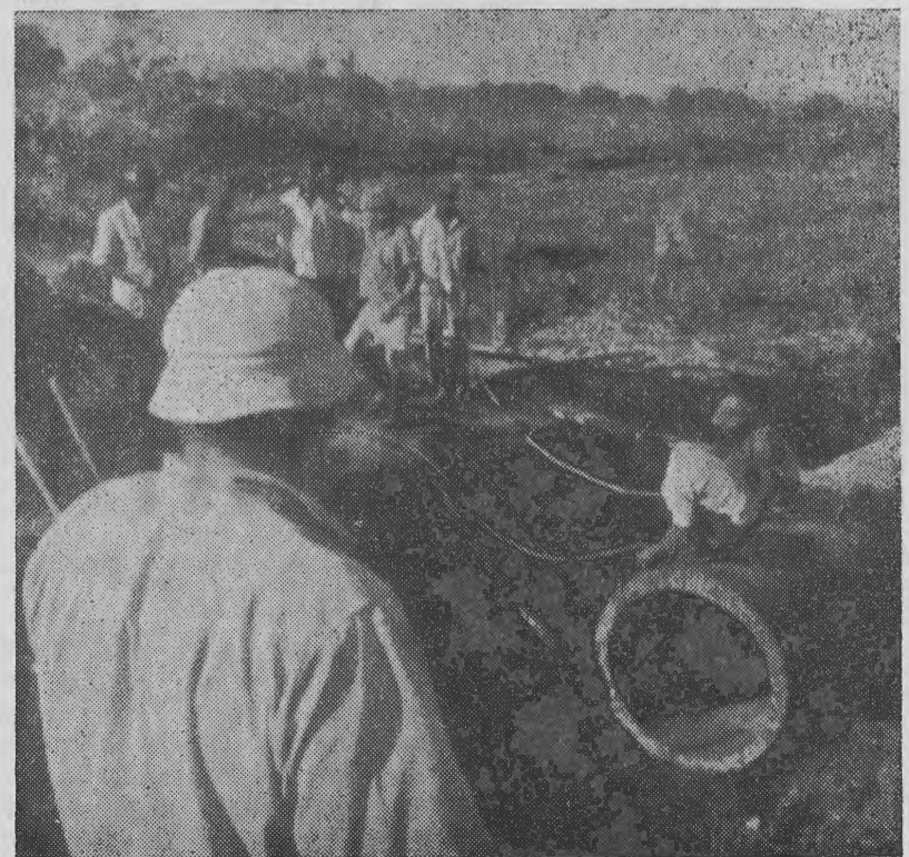
A PRIMEIRA PASSAGEM DE ÁGUA A SEGUIR À PONTE — EM MALHAS DE 1 METRO — ONDE PASSA ACTUALMENTE O INFULENE.
